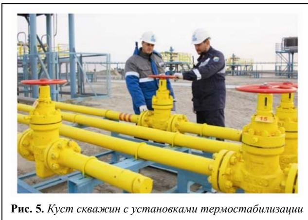
Рис. 5. Куст скважин с установками термостабилизации
