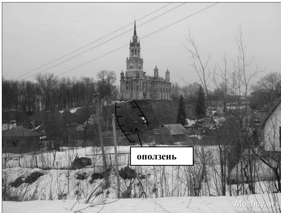
Рис. 1. Оползень. Юго-западный угол Ново-Никольского собора
